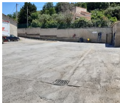
Grille de collecte des eaux pluviales
