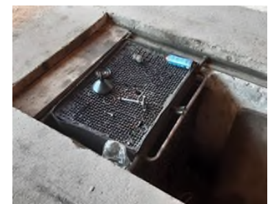
Grille de collecte des eaux pluviales
