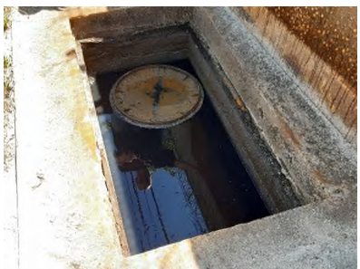
Séparateur d'hydrocarbures de la station de carburant
